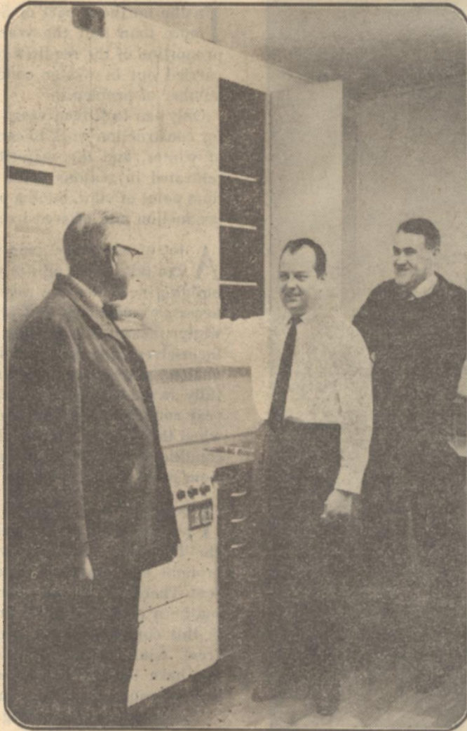
Köksinredningar har blivit norrforsfabrikens stora slagnummer. Direktör Sixten Sundström — till vänster på bilden — diskuterar med sin kamrer Lars Johansson och sin broder Nils Sundström, som är företagets verkställande.
